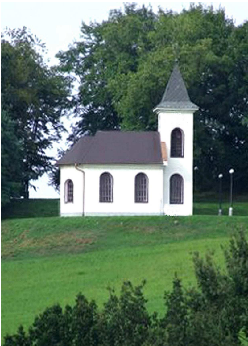
Kaple Navštívení Panny Marie po dokončení v roce 1993. Kaplica NNMP 1993 r.
