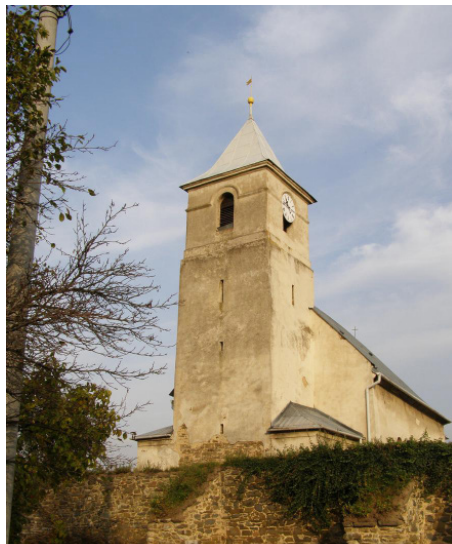
kostel před opravou
