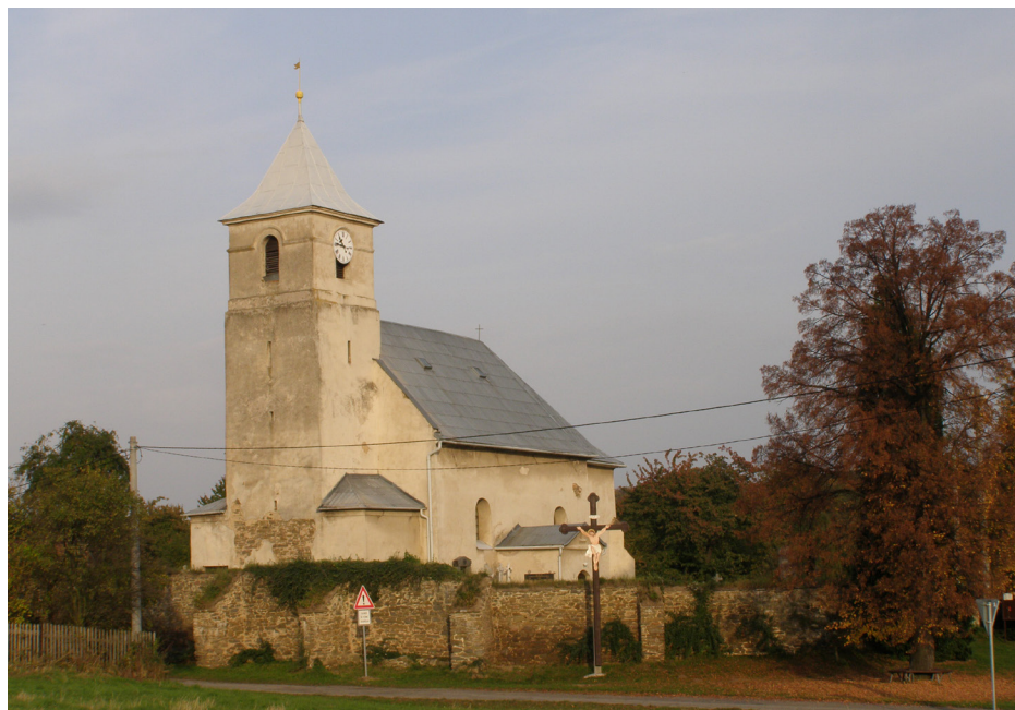
kostel před opravou
