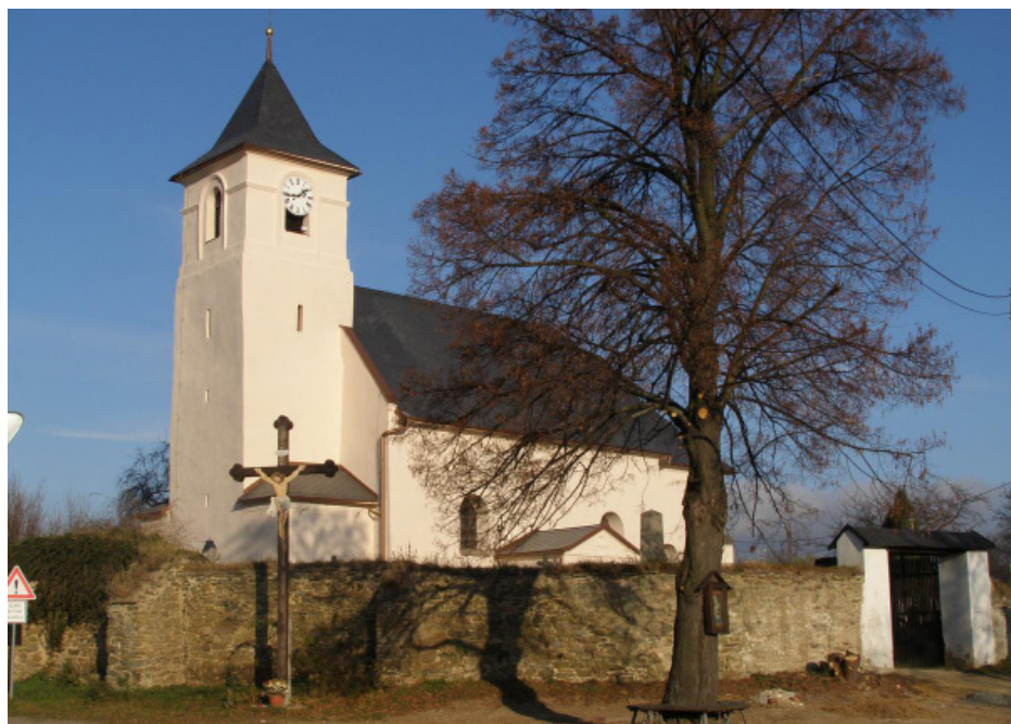
kostel po opravě
