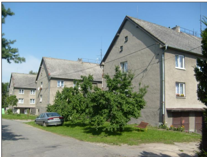
„Bytovky“ v Rusíně
